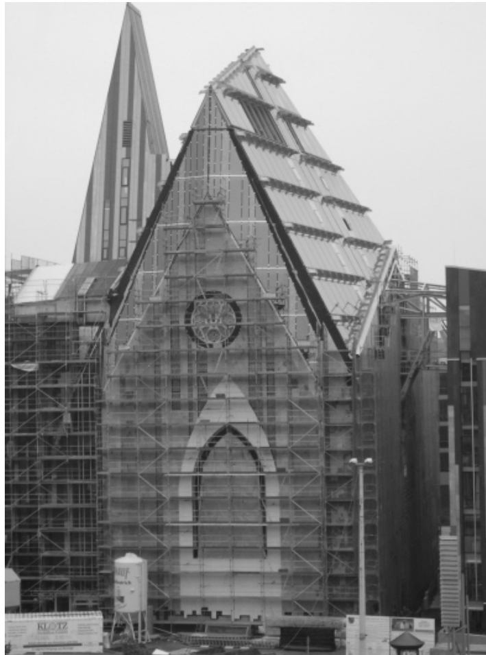
Baustelle der neuen Universitätskirche St. Pauli zu Leipzig (August 2010)
